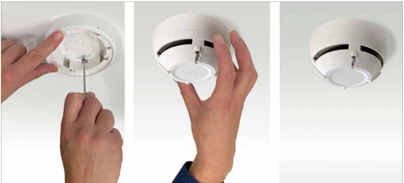
Рис. 4. Монтаж радиосистемы «Стрелец-ПРО» – в 5 раз быстрее монтажа проводных решений
