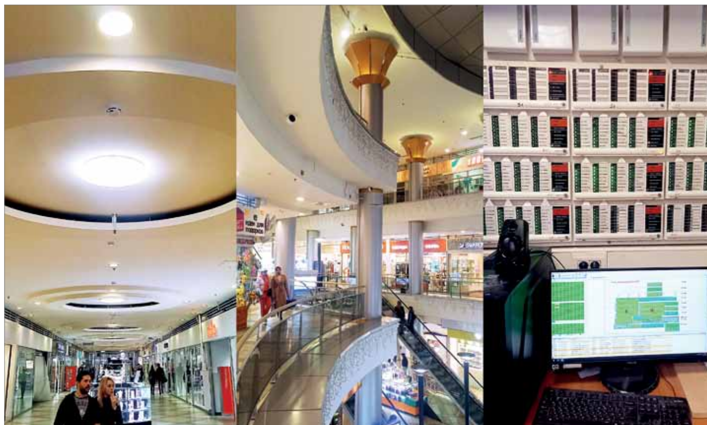
Рис. 2. «Стрелец-ПРО» позволил провести переоснащение без остановки работы ТРК «Сенная»
