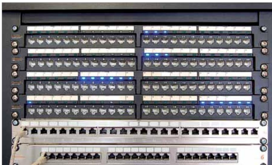
Рис. 1. Стандартная система мониторинга NIKOMAX
