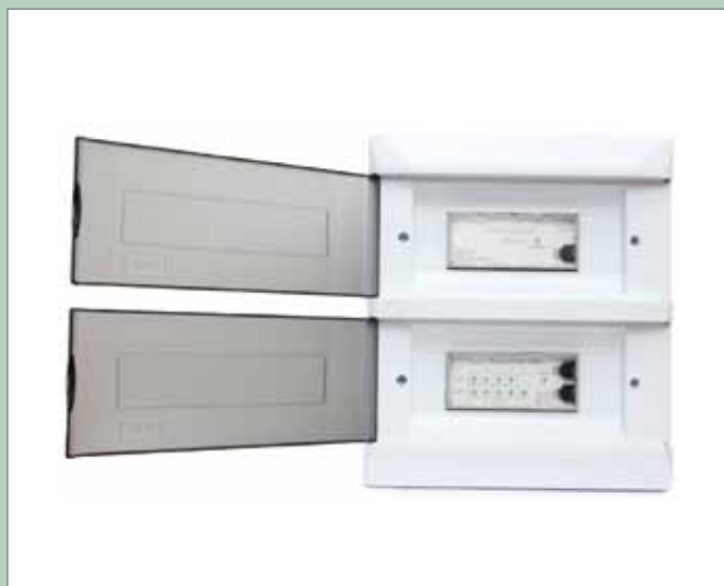
Рис. 3 Установка в распределительный щит
