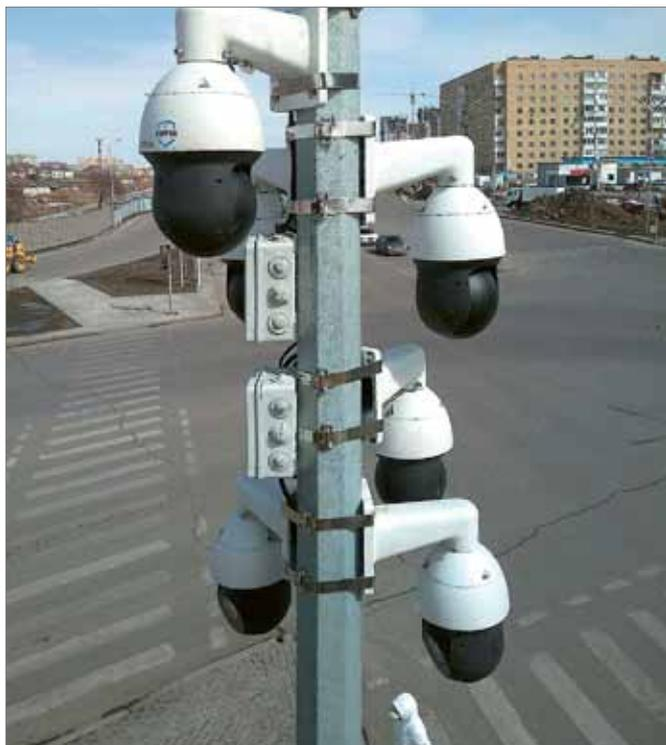
Рис. 2. В проекте используется ПО Macroscop и IP-камеры Dahua
