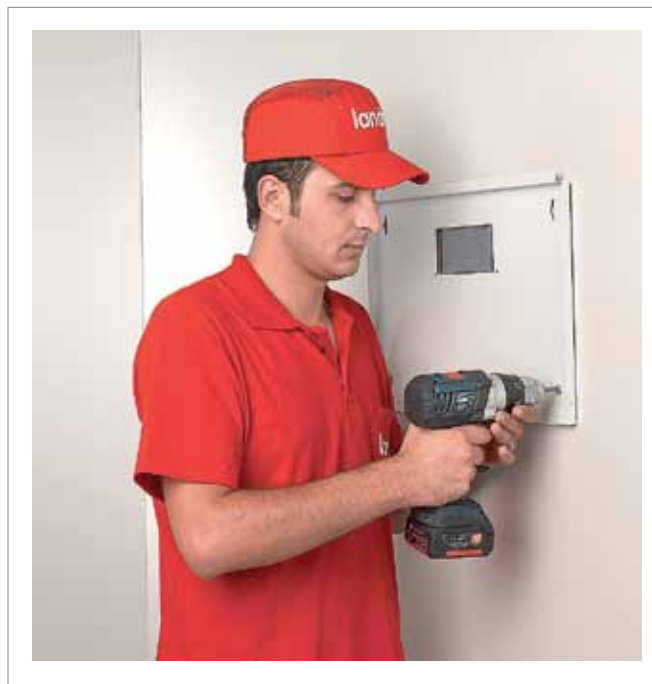
Фото 6. Шкаф серии NetboxSoho легко монтируется одним человеком, сначала к стене привинчивается задняя стенка потом на нее навешивается шкаф
