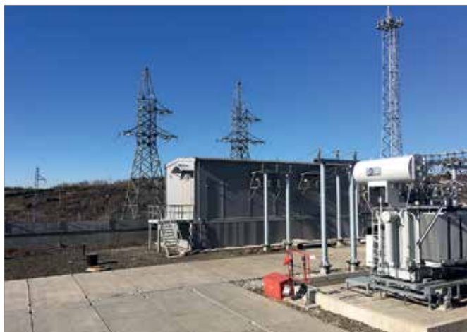
Фото 4. Кемеровская область. Подстанция «Сычёвская». Контроль перегрева кабелей.
