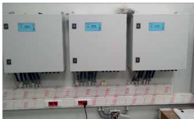
Фото 7. Москва. Аэропорт Шереметьево. Блоки обработки ИПТЛ «ЕЛАНЬ».
