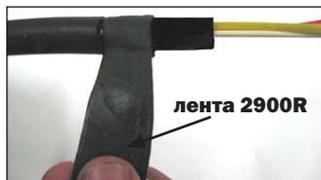
**5.5** Ввести нижнюю часть соединителя Scotchlok 4460-D между внутренней оболочкой с наложенной на нее лентой 2900R и наружной оболочкой, под стальную гофрированную ленту.
