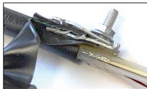
**4.5** Закрепить на ОК соединитель обмоткой из 2-3 слоев ленты виниловой с 50 % перекрытием.
