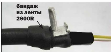
**5.7** Установить на нижнюю часть соединителя Scotchlok 4460-D верхнюю часть соединителя и скрепить обе части гайкой. Наложить на соединитель и на прилегающие к нему участки ОК бандаж из двух-трех слоев ленты виниловой на длине около 10 мм.
